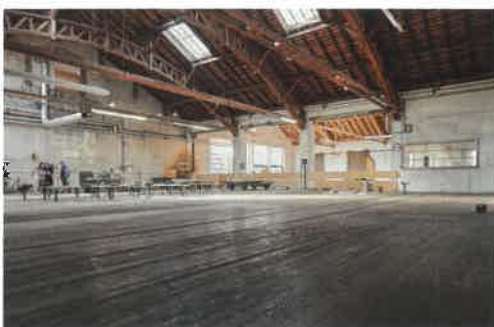
Die alte Hobelwerkhalle wird zum Treffpunkt.
