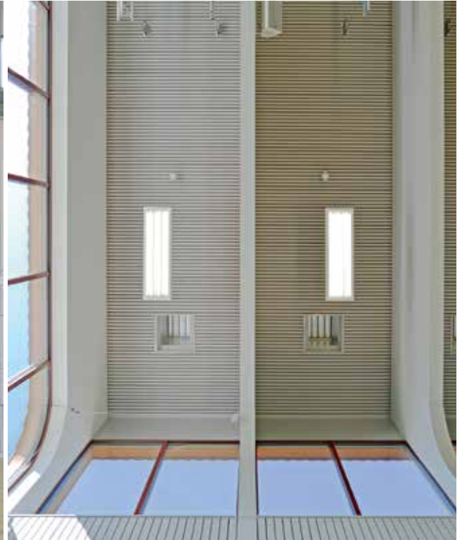
Ein Blick unter das Hallendach zeigt den Holzbau auf dem Lichtband, welches das Gebäude umsäumt.
