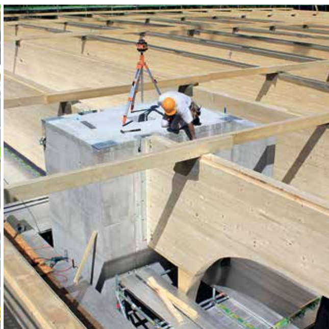
Perfekte Kombination: der Erschliessungskern aus Stahlbeton und der elementbasierte Holzbau.
