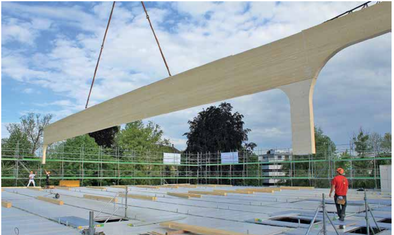
Über 30 m gross und doch millimetergenau: dank CNC-Präzisionsabbund.
