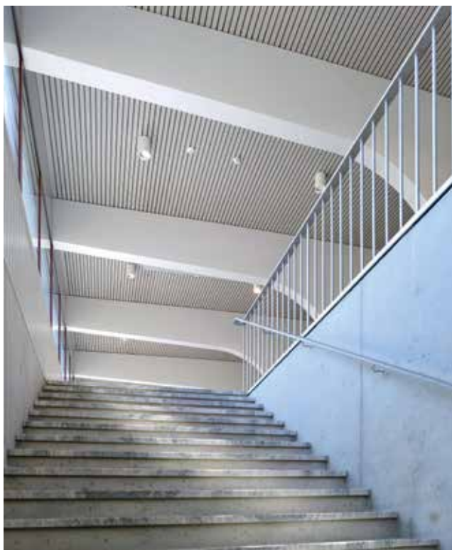
Die beiden Treppenhäuser dienen der Aussteifung und Lastabtragung des Gebäudes.
