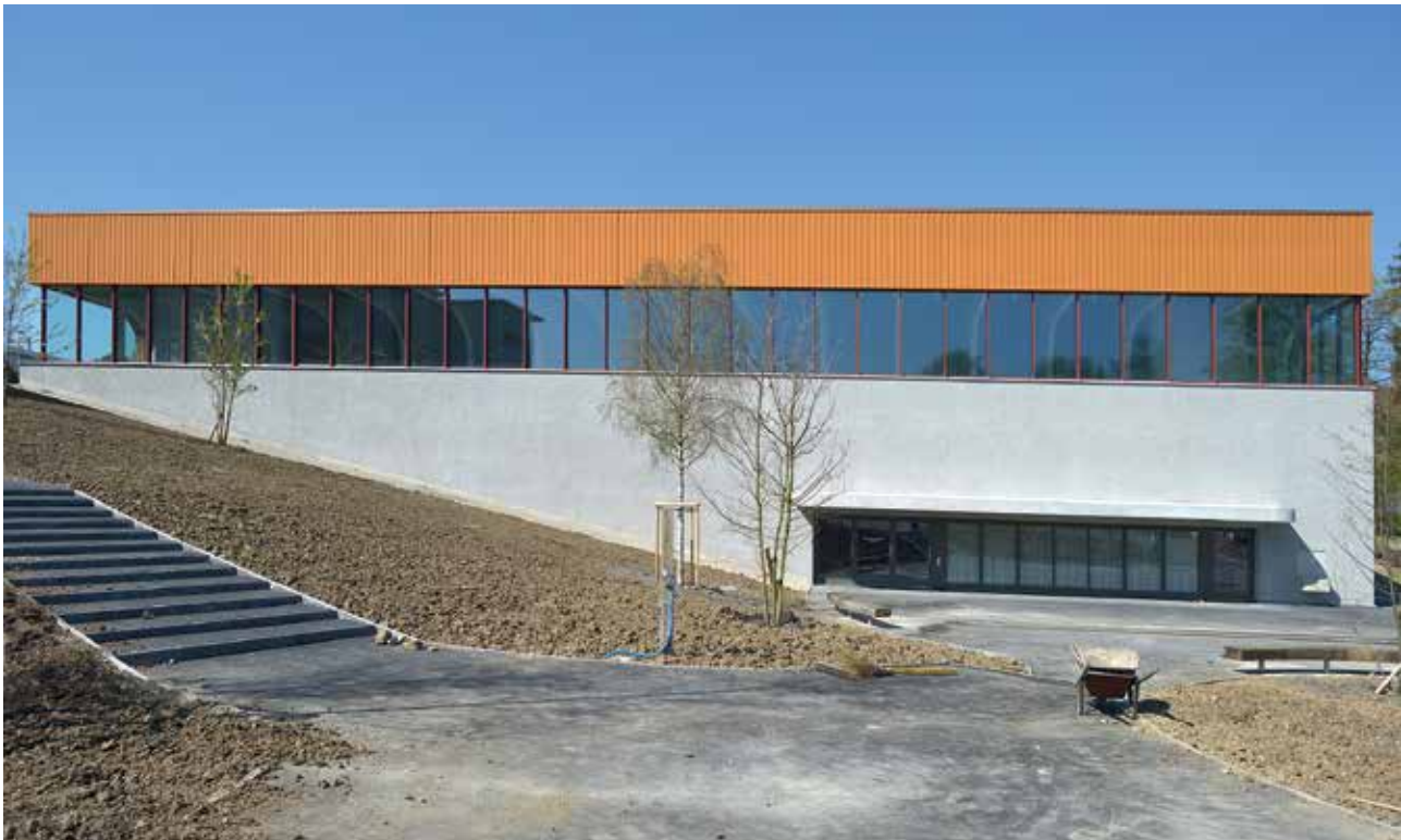
Die leichte Hanglage bedingte das Fundament und die Schalung aus Stahlbeton, auf die der holzbauliche Teil platziert wurde.
