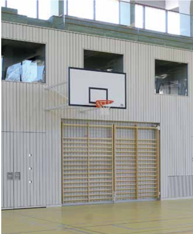
Auch die Innenwände der Sporthalle wurden mit Holz bekleidet: der Akustik und der Belastbarkeit wegen.
