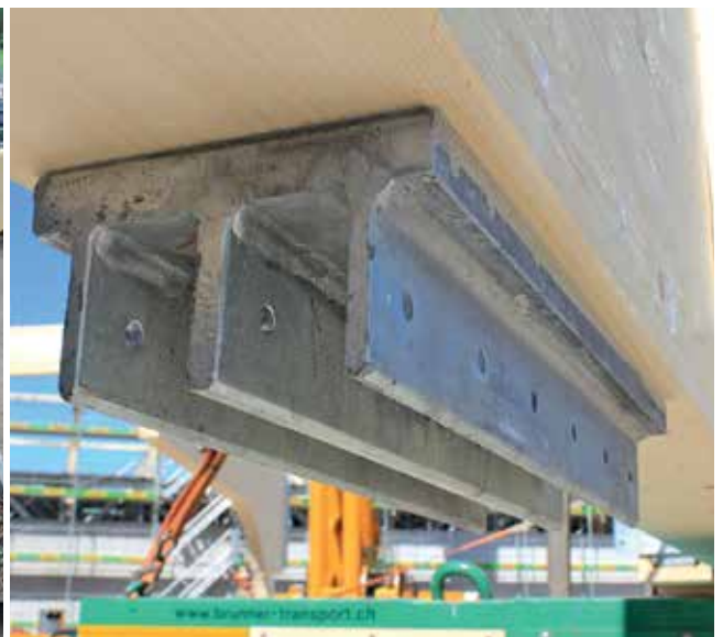
Es sind die effiziente Verbindung und der erfahrungsbasierte Einsatz unterschiedlicher Materialien, die den Holzbau heutiger Prägung auszeichnen, wie hier das Anschlussisen des BSH-Trägers.
