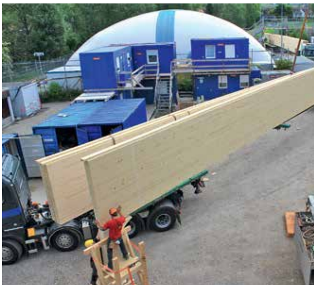
Die Dimensionierung der BSH-Träger bedingt sich nicht zuletzt durch die Baustellensituation und durch die logistischen Möglichkeiten der zu bewältigenden Wegstrecke ab Werk.
