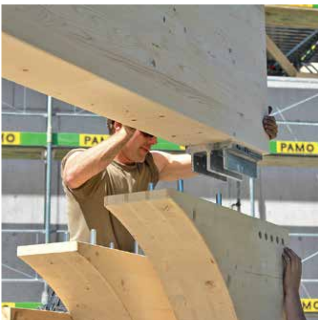
Vormontage eines BSH-Trägers mit der Stahlverbindung und Gewindestangen.
