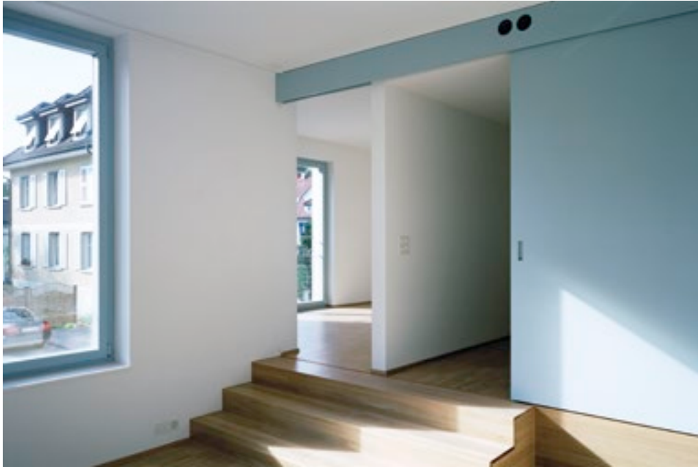
Raumhierarchien: In zwei der Wohnungen im Hochparterre ist der Boden des Wohnzimmers leicht abgesenkt, woraus eine grössere Raumhöhe resultiert.
