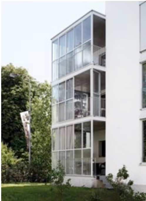
Seitenblicke: Das leichte Verschieben der Veranden aus der Flucht des Bauvolumens erlaubt Aussicht in drei Richtungen.
