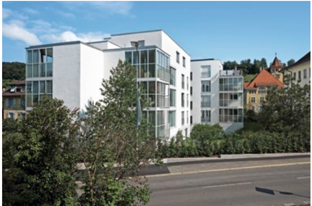
Ansicht von Süden: Die zahlreichen Versprünge des Volumens unterstützen die Integration des Neubaus in das kleinteilige Quartier.
