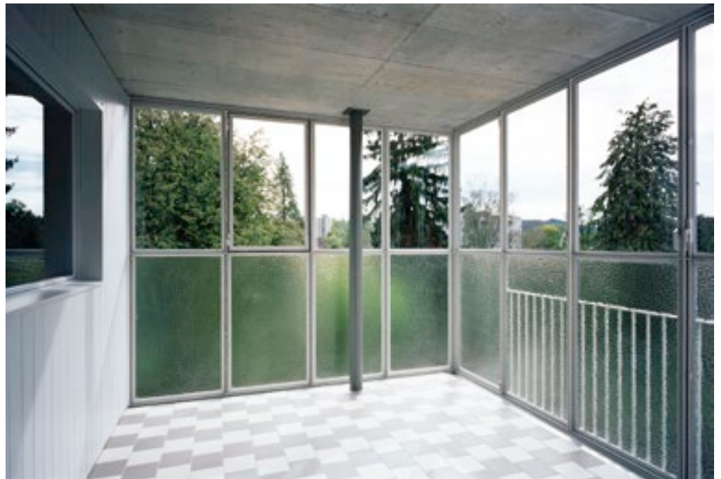
Die grossen Veranden werden durch das Kathedralglas im unteren Bereich der Verglasung horizontal geteilt.
